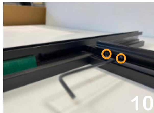
Pré-placez le verre en commençant par y placer les cales de vitrage (voir plan précédent). Insérez le verre ou un gabarit pour régler l'espace entre les montants. Enfin resserrez les vis des équerres du montant et du cadre (image 10).
