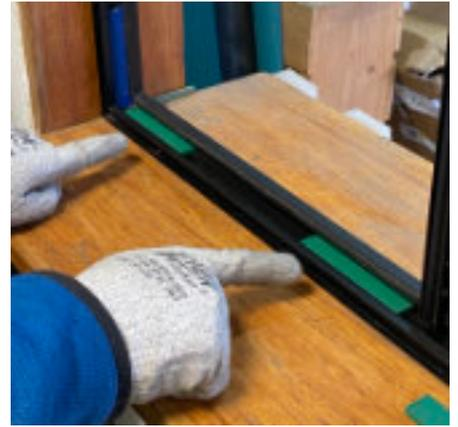
Commencez par placer le cadre pour repérer les emplacements de perçage puis vissez-le au support. Une fois le cadre fixé, placez les cales de vitrage comme indiqué en photo ou sur la page assemblage du cadre.
